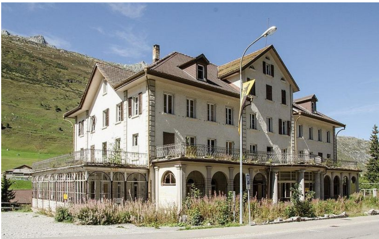
Das ehemalige Hotel Meyerhof in Hospental (UR).
