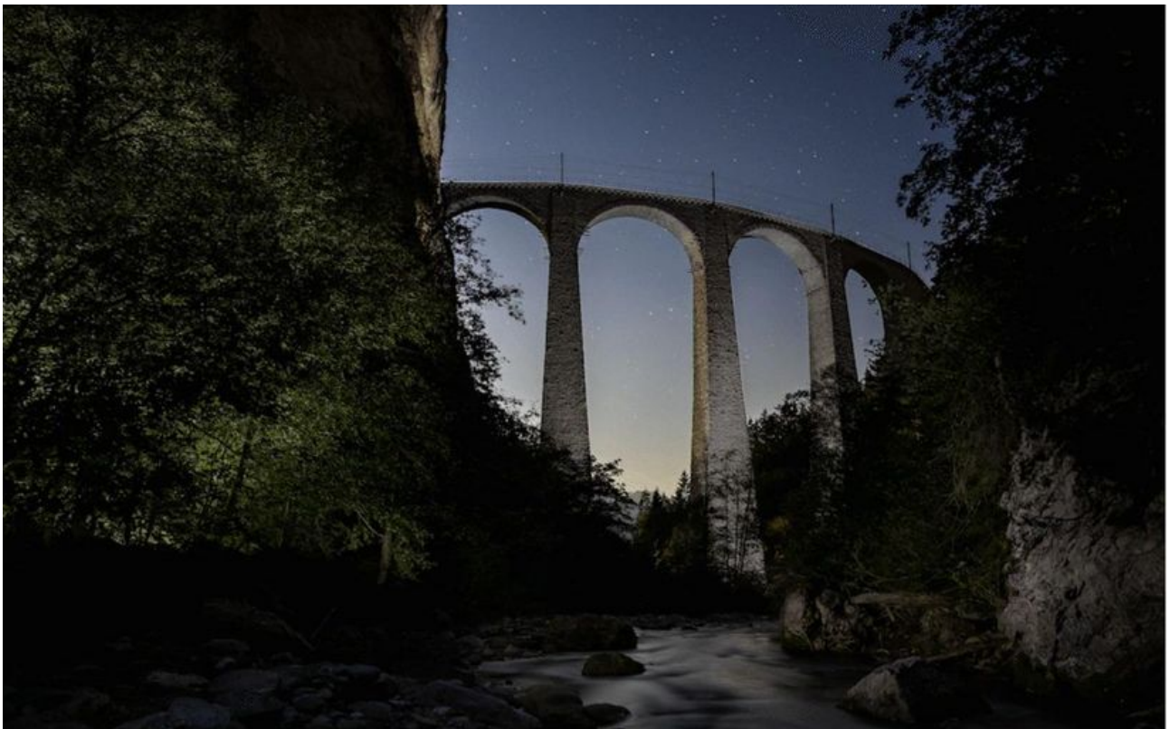
Eine nächtliche Wanderung führt zum Landwasserviadukt.
