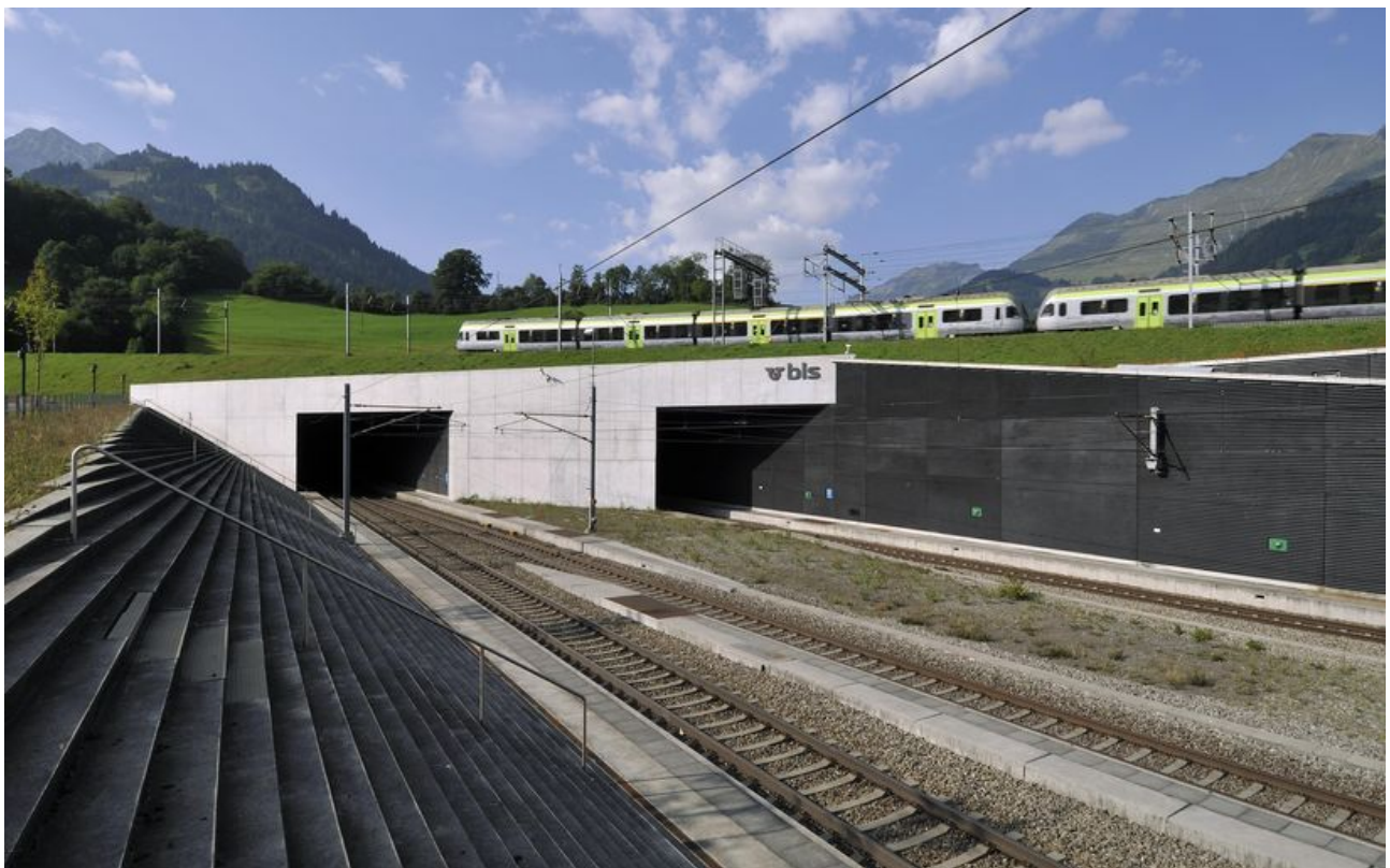
Das Nordportal vom Lötschberg-Basistunnel.
