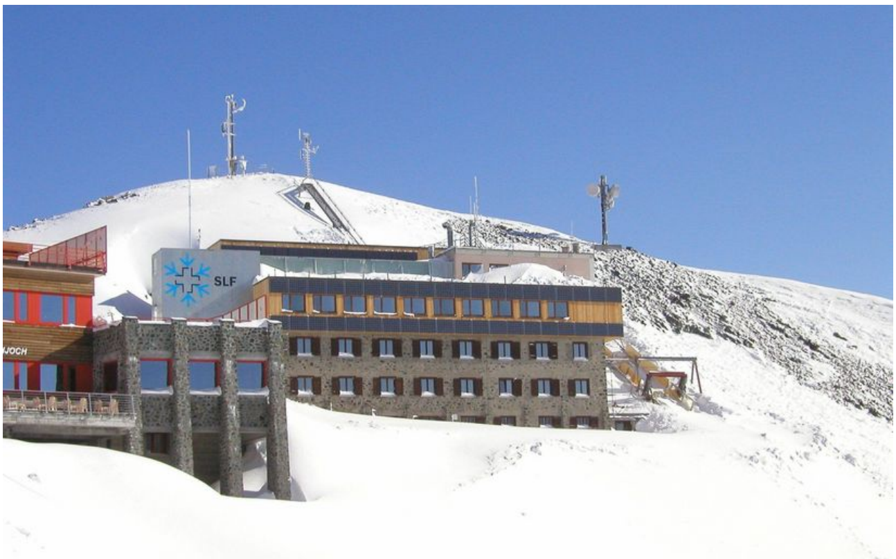
SLF-Institutsgebäude auf dem Weissfluhjoch
