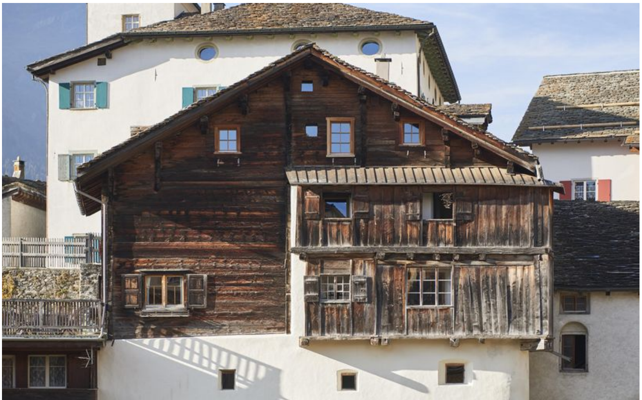
Aussenansicht Sust (Fassade mit Laube).
