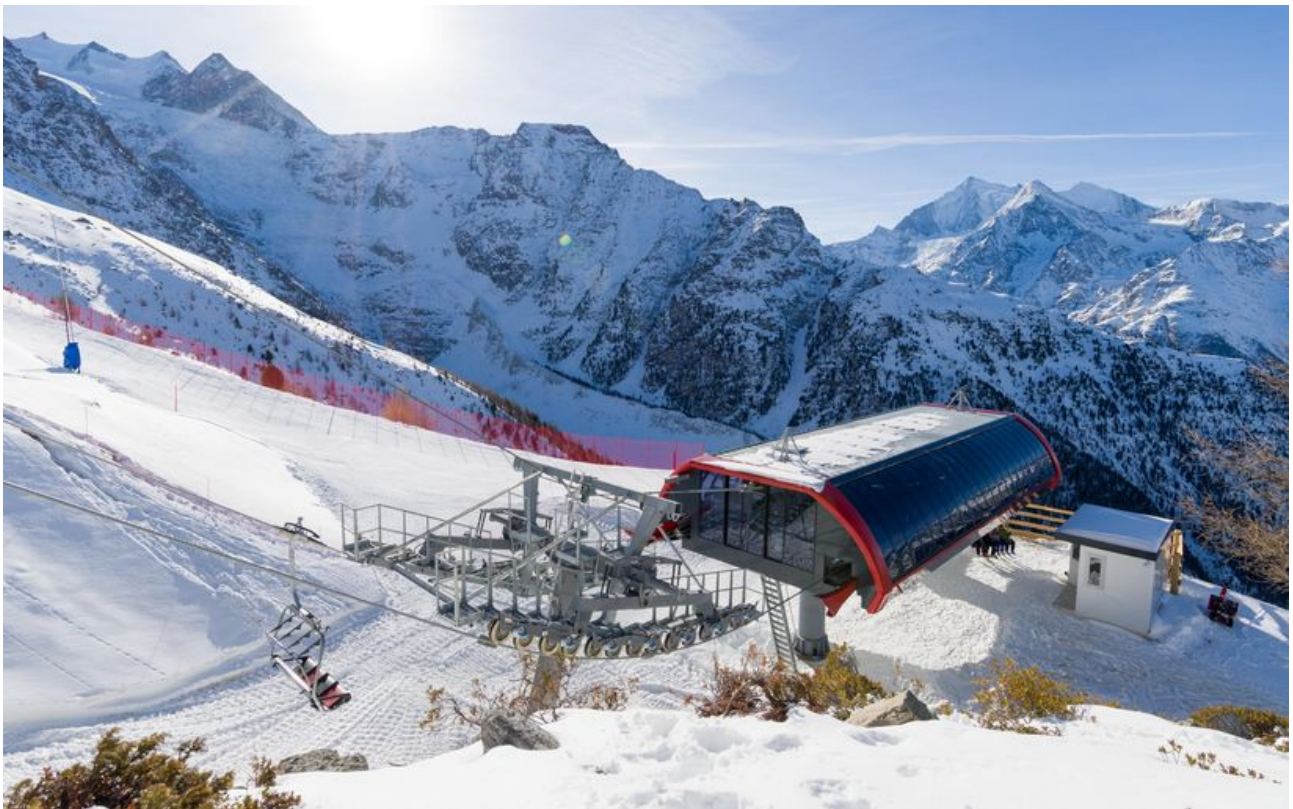
Talstation der neuen Sesselbahn Plattja.
