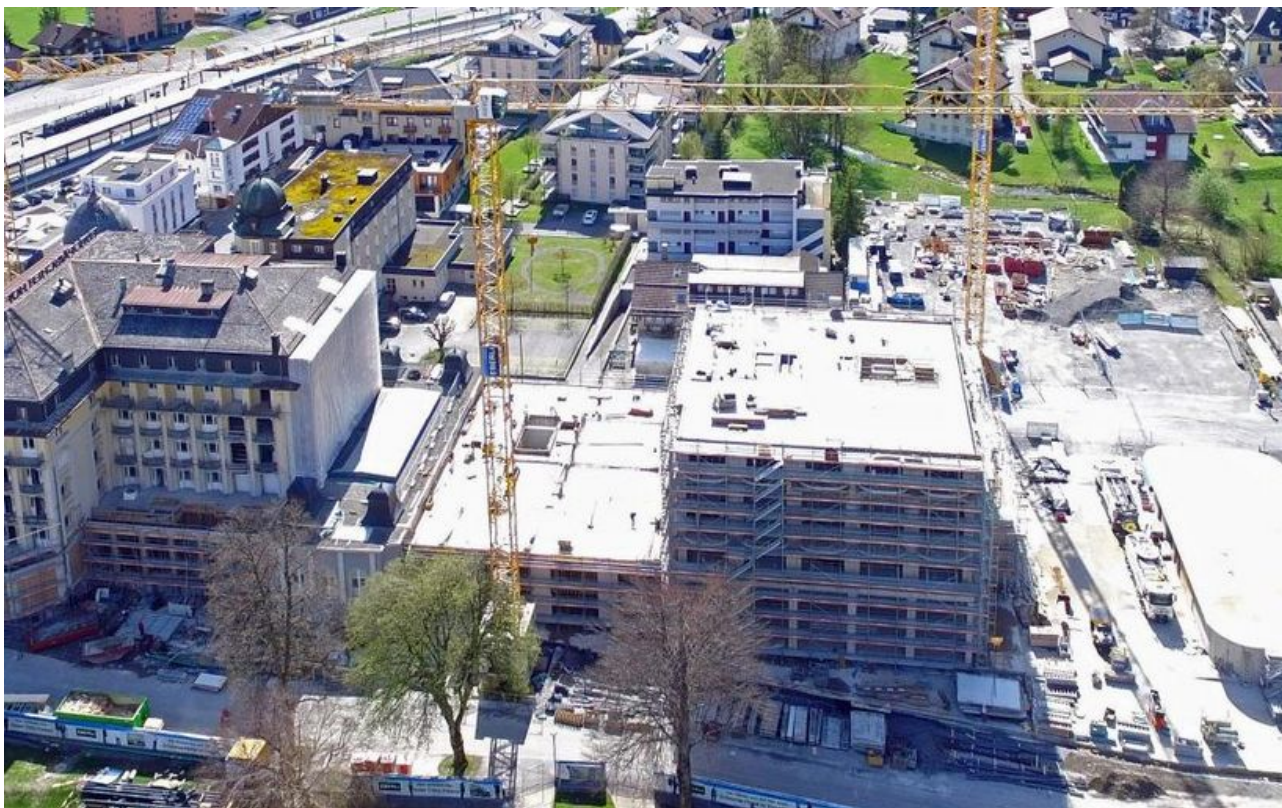
Drohnenaufnahme von der Baustelle des Grand Hotels Titlis, Engelberg.
